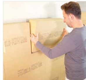
Verlegung kleinformatiger stumpfer Platten
