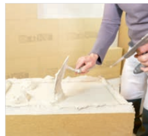
Dämmplatte ankleben auf unebenem Untergrund im Punkt-Wulst-Verfahren
