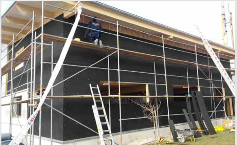
Die fertige Unterkonstruktion für die vorgehängte Fassade: STEICO *universal black* auf Holzständerwerk
