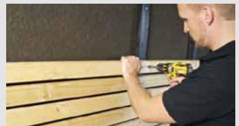
5. Anbringen der vorgehängten Fassade, z.B. Rhombusschalung. Die maximale Fugenbreite beträgt 20mm, wobei das Deckmaß der Fassadenbekleidung mindestens das dreifache der Fugenbreite beträgt.
