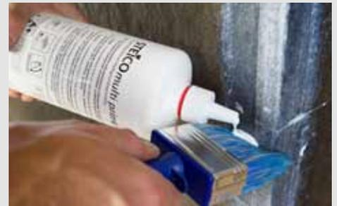
2. Stumpfe Stöße werden mit UV-stabilem Klebeband abgeklebt. Die Vorbehandlung mit STEICO *multi primer* schafft einen hervorragenden Haftgrund.
