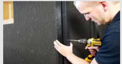
4. Schwarz lasierte Latten dienen als Unterkonstruktion für die eigentliche Sichtfassade.
